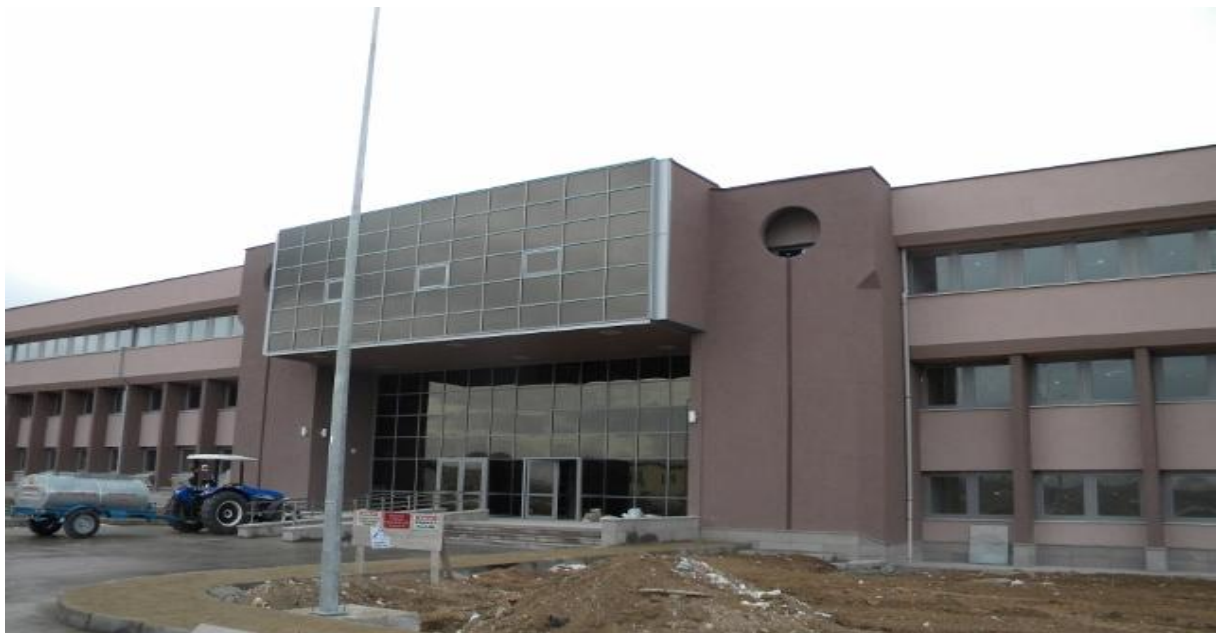
Gölbaşı Yerleşkesi BESYO Bina İnşaatı
