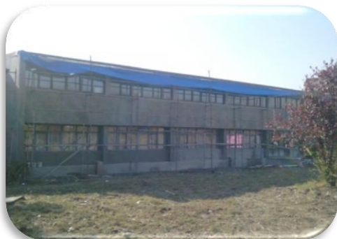
Ankara Üniversitesi Ziraat Fakültesi Su Ürünleri Binası Dış Cephe ve Çatı Onarımı ile Doğrama Değişim İşi
