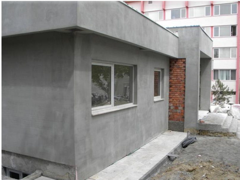
Kordon Kanı ve Kök Hücre Bankası Bina İnşaatı
