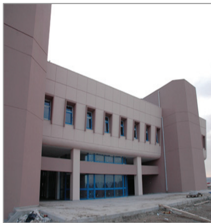
Gölbaşı-Virancık Kampüsü İnşaatlarından bir görünüm
